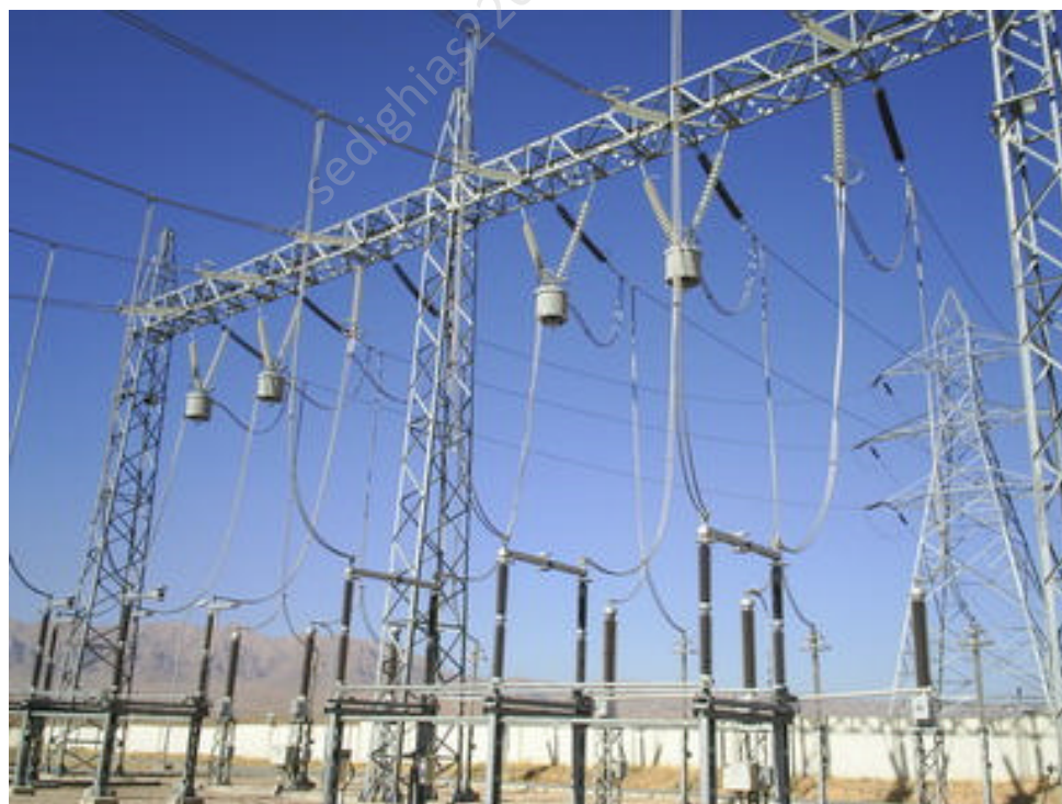
آرایش فیزیکی لاین تراب ها در ورودی ایستگاه =====
