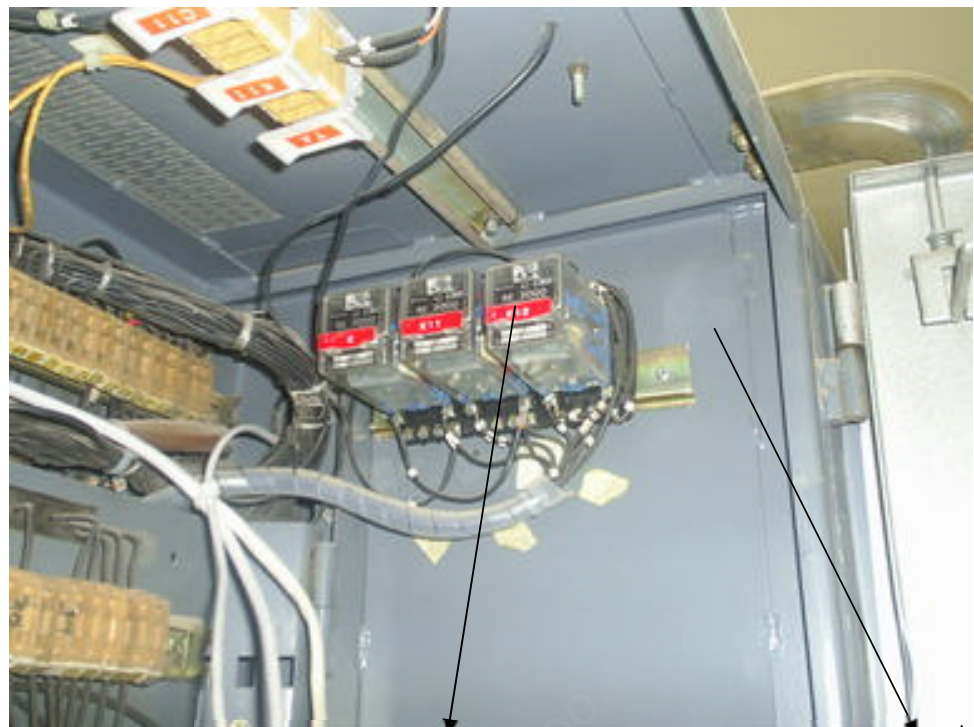
رله تجهیزات HVI تعبیه شده در ترانس
