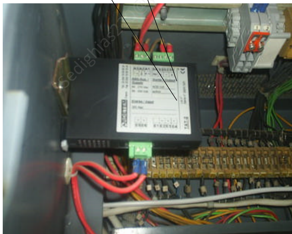
رله تجهیزات HVI تعبیه شده در ترانس
