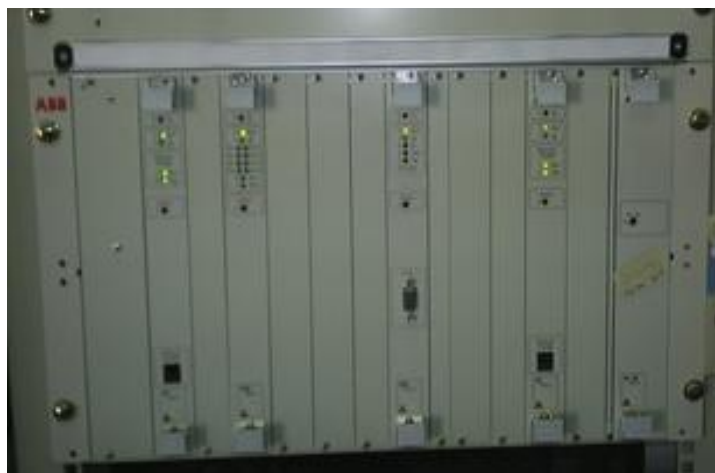
از راست به چپ: کارت Rx، کارت LF، کارت پروسسور مرکزی، کارت
