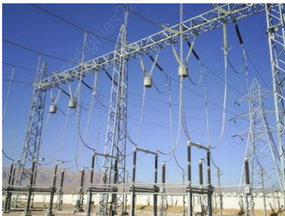
آرایش فیزیکی لاین تراب ها در ورودی ایستگاه =====
