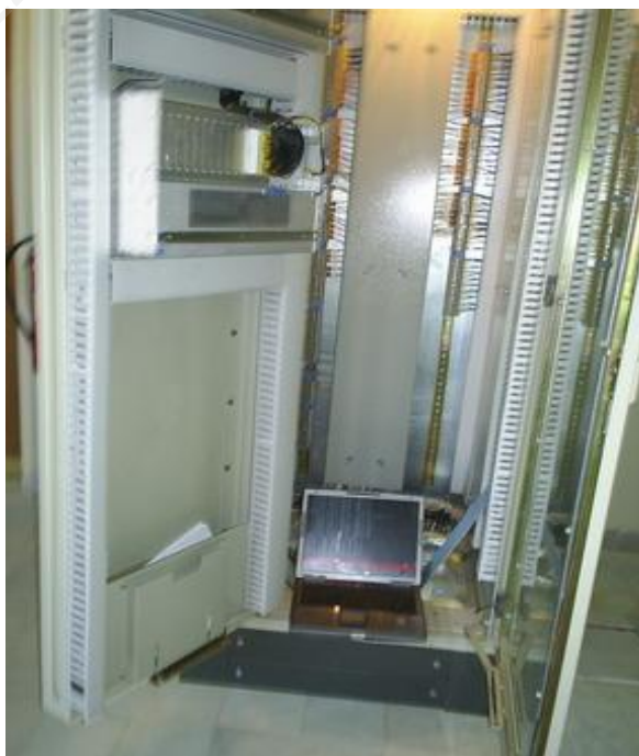
اجزاء RTU و یک کامپیوتر (رایانداگاه 230)
