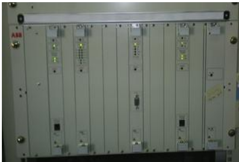
از راست به چپ: کارت Rx، کارت LF، کارت پروسیسور مرکزی، کارت حفاظت، کارت
