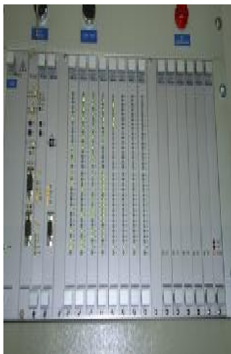
کارت‌های شاسی بالایی RTU
