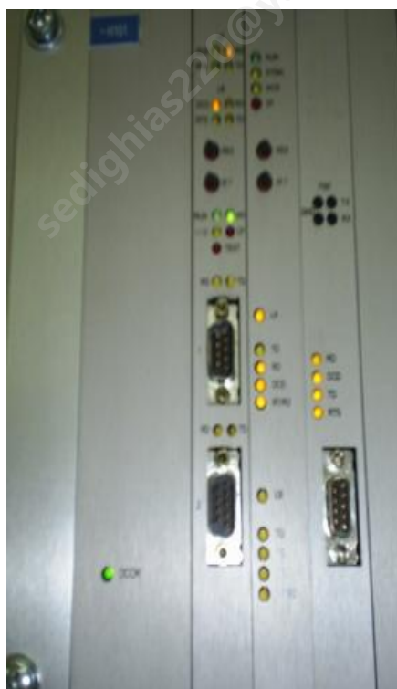
به ترتیب از راست: کارت مودم، کارت I-COM، کارت CPU، کارت
