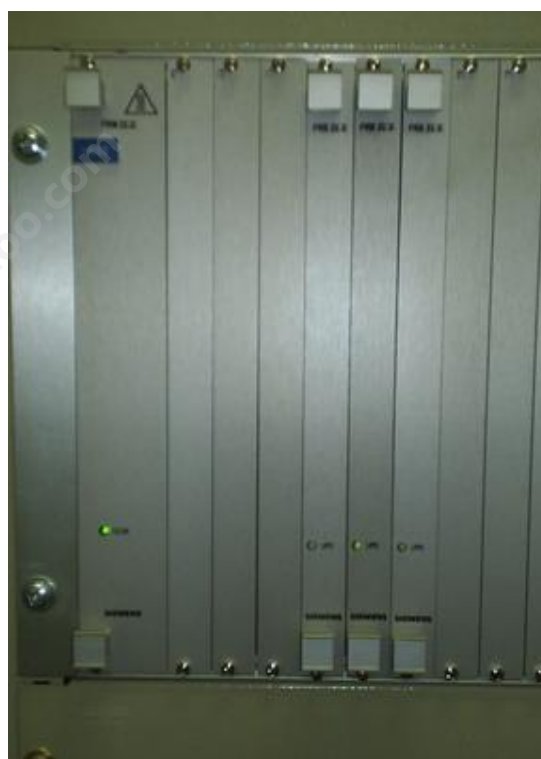
کارت‌های آنالوگ و کارت تغذیه شاسی پایینی
