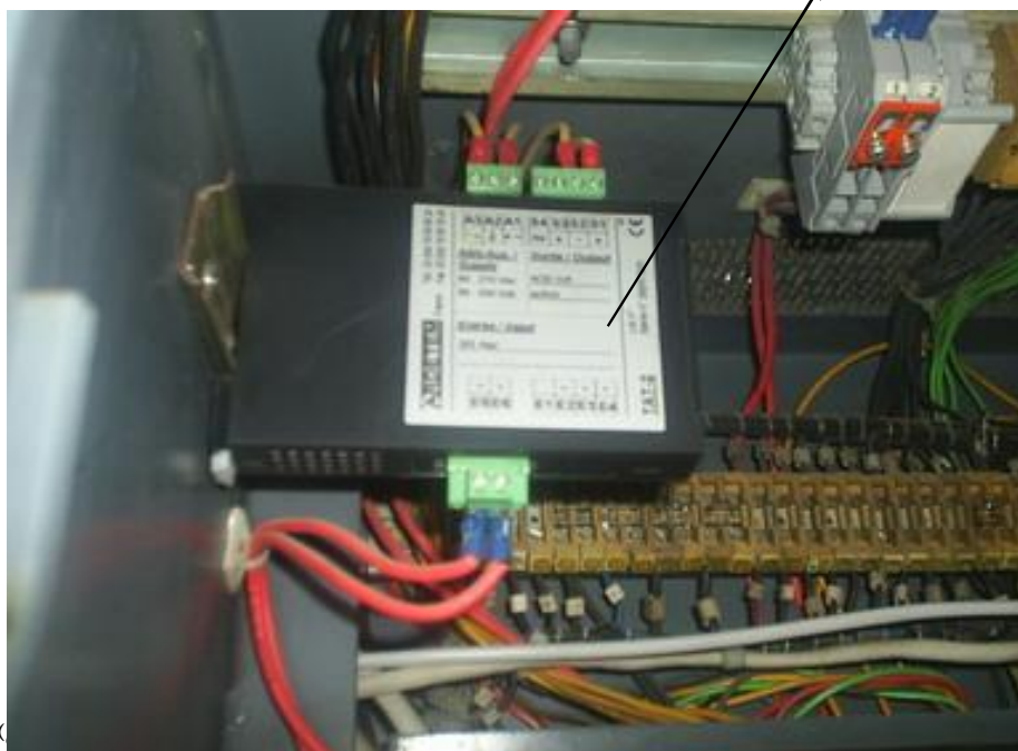
ترانسدیوسر تجهیزات HVI در فیدرهای خروجی رله ها
