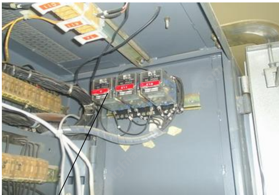
ترانسدیوسر تجهیزات HVI در فیدرهای خروجی رله ها
